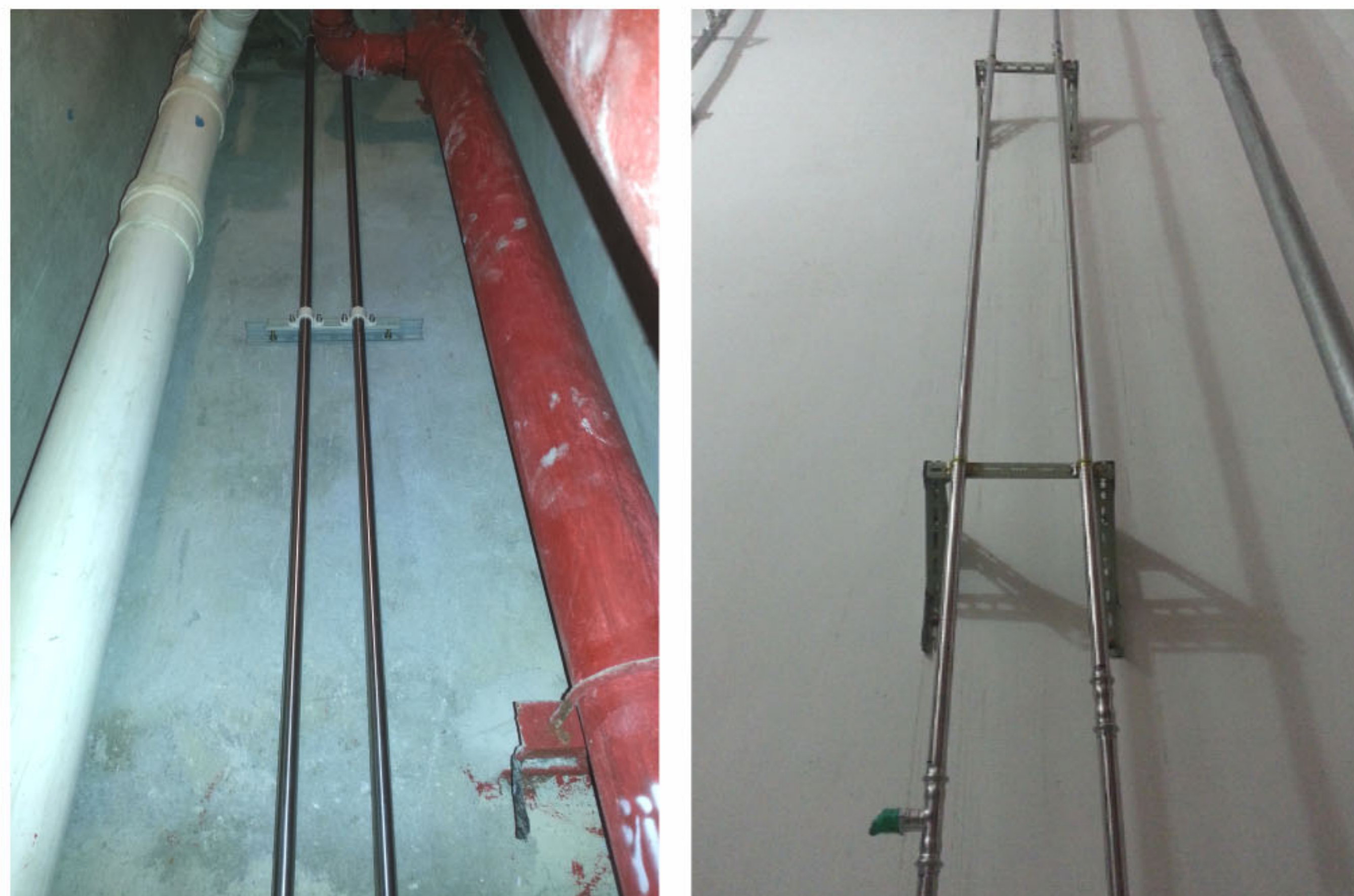
不锈钢管道工程实景图
